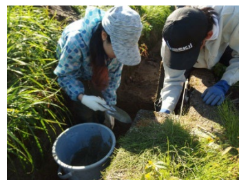
<鳥取県鳥取市（R元モデル事業）> 地方の農業に関心のある都市部からの 滞在者との協働による農業用水路の修繕
