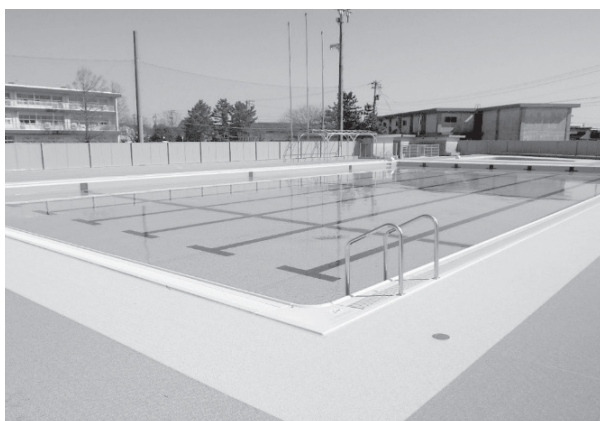
黒部市生地小学校プール耐震補強工事
