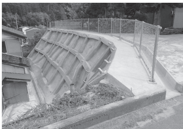
高岡市急傾斜地の法面保護工事
