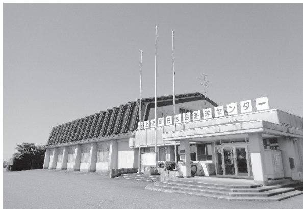
上市町B&G海洋センター体育館大規模改修事業
