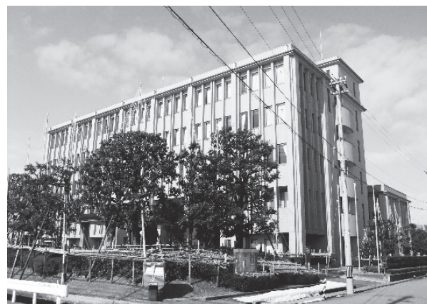
富山県市町村会館全景（H7年11月開館）
