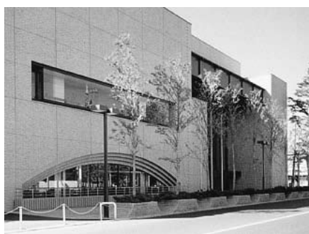
武蔵野市市民文化会館改修工事
